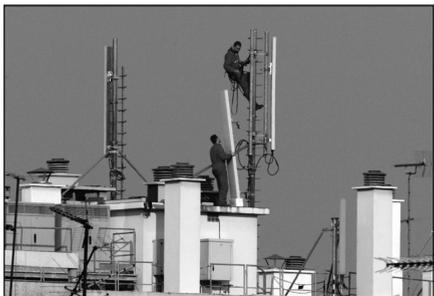
Doc. 3 Installation d'une antenne relais sur le toit d'un immeuble.
